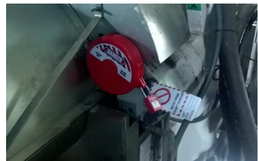
Consignación del bulón de bloqueo en el tren de potencia. Locking and tagging out of the drive shaft blocking bolt.
