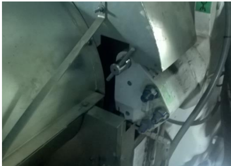
Instalación del sistema de bloqueo. LOTO system installation.
